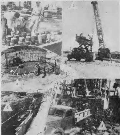
Aki 'riba nos ta mira varios sortu di a trabao cu ta worde haci n'e departamento di Beton, cual ta un di e departamentonan mas ocupá di e refinaria.
